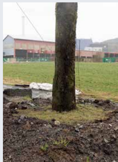
Rundt rotklumpene er det pakket ny jord ved hjelp av gravemaskin.
